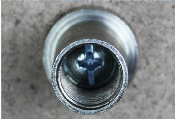
使用 M5 螺絲，將鋼索懸吊頭固定在鑽孔處
