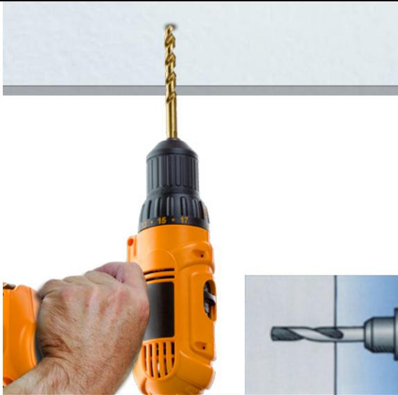
使用電鑽鑽出  $\Phi 7 \times 40\text{mm}$  的孔徑在天花板上
